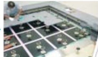
OAパネルの設置
